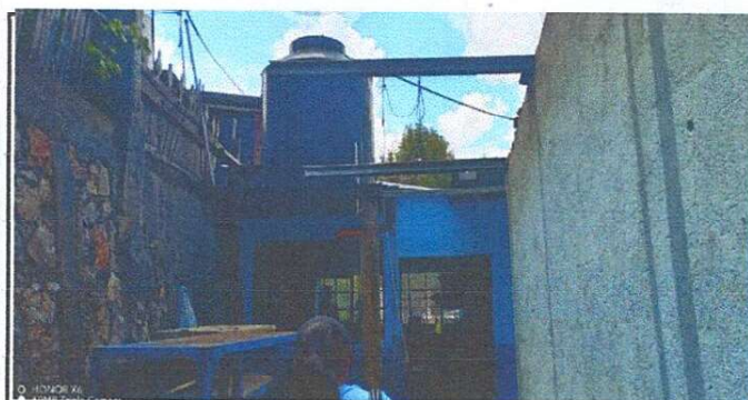
Foto 5: Verificación de espacios a intervenir.
