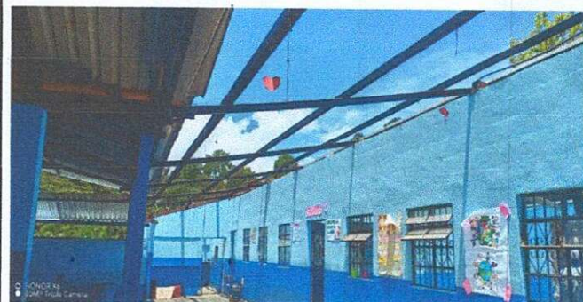
Foto 2: Destechado de las aulas.
