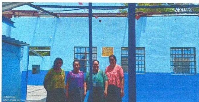
Foto 1: Destechado de las aulas a rehabilitar
