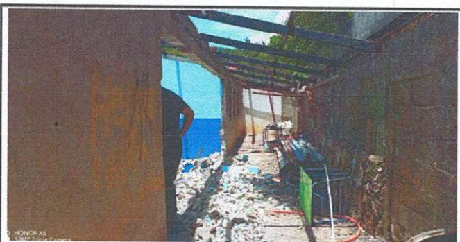
Foto 6: Eliminación de paredes que se necesitan rehabilitar,
